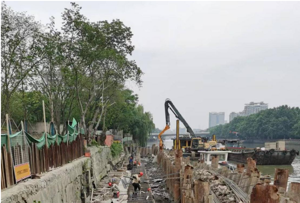
水上施工作业
